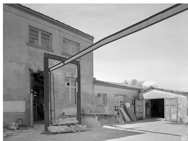
Partie nord des bâtiments. Phot. Raphaël Jean IVR54_20017902229V
