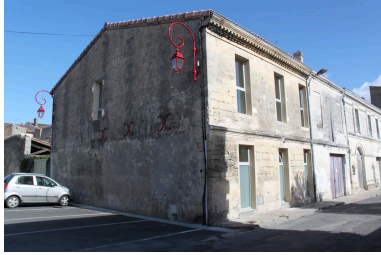
Vue d'ensemble. Phot. Claire Steimer IVR72_20123304964NUCA
