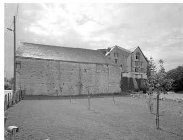
Vue prise du nord-est. Phot. Christian Rome IVR54_20017902195V
