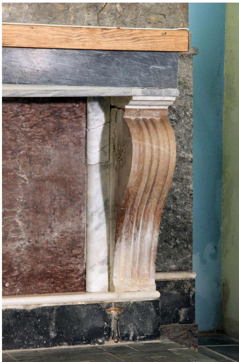
Détail d'une console de l'autel.
