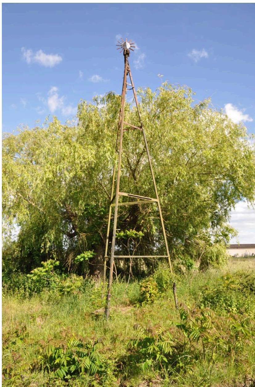
Puits et vestiges d'une éolienne.
