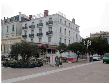
Elévations depuis le boulevard Promenade Veyrier Montagnères et la place Thiers. Phot. Bertrand Charneau IVR72_20103302108NUC2A
