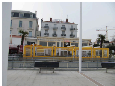
Ensemble depuis le boulevard Promenade Veyrier Montagnères. Phot. Bertrand Charneau IVR72_20103302107NUC2A
