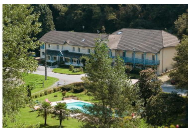
Vue d'ensemble depuis le nord-ouest. IVR72_20196401943NUC2A
