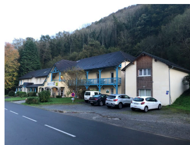
Hôtel-restaurant Au Bon Coin. Élévation principale. Phot. Viviane Delpech IVR72_20196402481NUC2A
