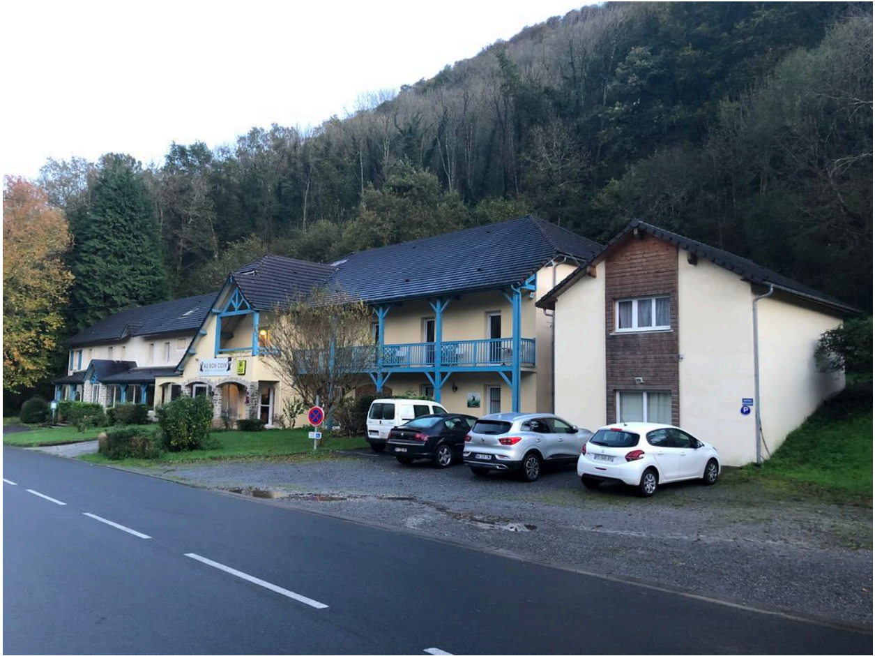
Hôtel-restaurant Au Bon Coin. Elévation principale.
