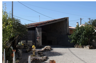
Une vue du hangar placé dans la cour antérieure, depuis le nord-est.
