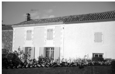
Le logement et les dépendances de l'ancienne ferme; depuis le sud.
