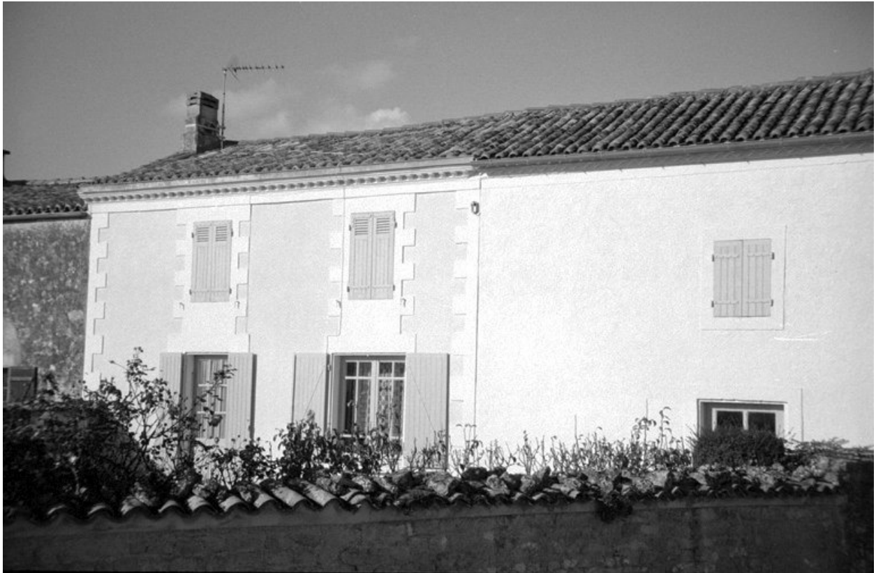
Le logement et les dépendances de l'ancienne ferme; depuis le sud.
