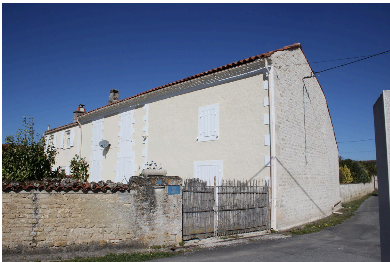
Une vue du logement de l'ancienne ferme et des dépendances accolées, depuis le sud-est.
