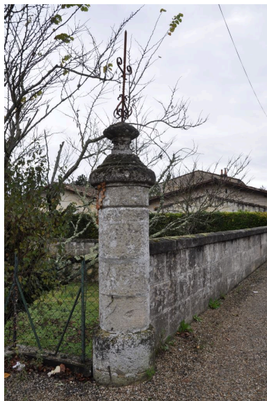
Clôture : pilier situé à l'ouest. Phot. Jennifer Riberolle IVR72_20183300557NUC2A
