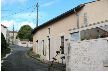
Le bâtiment principal. Phot. Pierrick Barreau IVR54_20171709832NUCA
