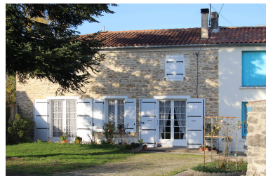
Une vue du logement de l'ancienne ferme, depuis le sud-est. Phot. Nathalie Lhuissier IVR75_20191701609NUCA
