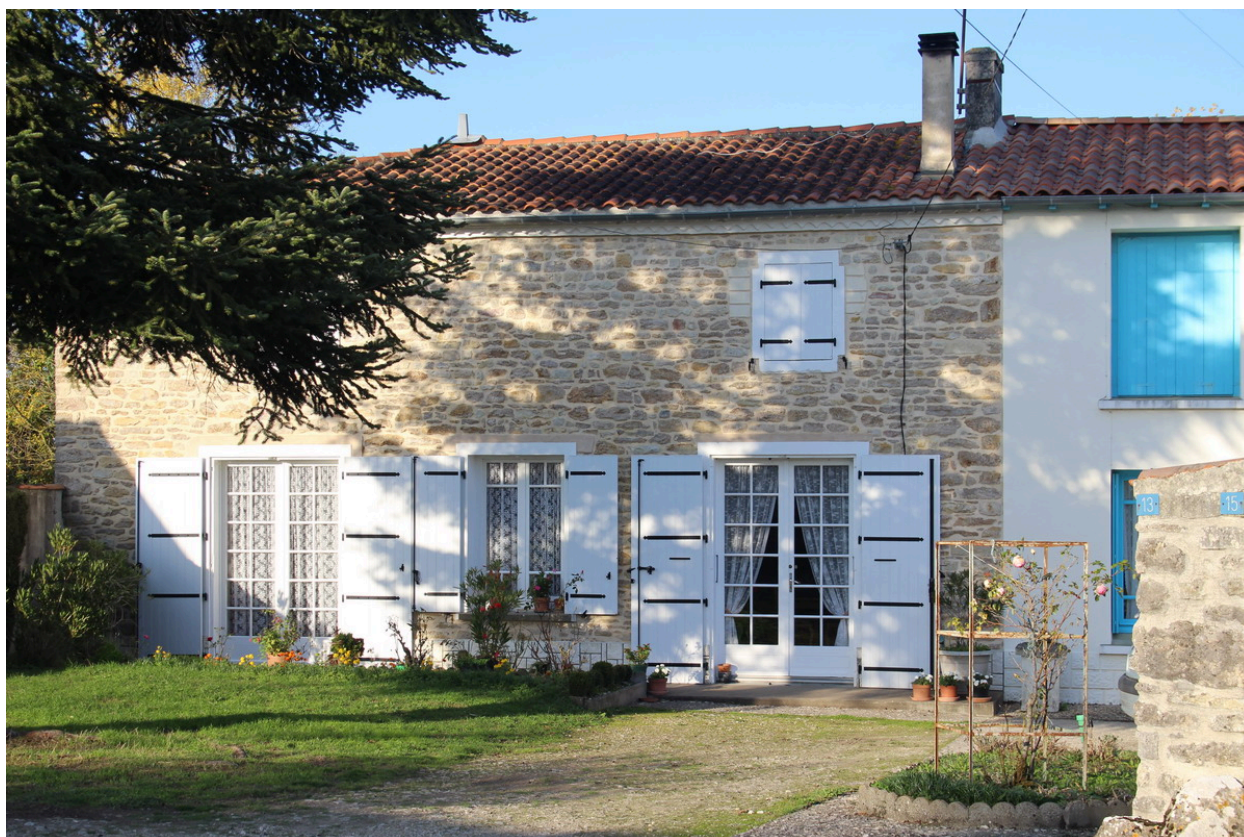
Une vue du logement de l'ancienne ferme, depuis le sud-est.
