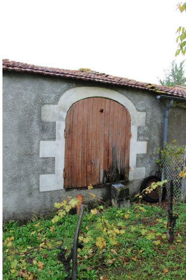
Détail de la baie de décharge. Phot. Claire Steimer IVR72_20143303449NUC2A
