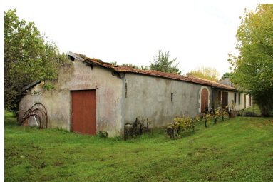
Vue d'ensemble. Phot. Claire Steimer IVR72_20143303448NUC2A
