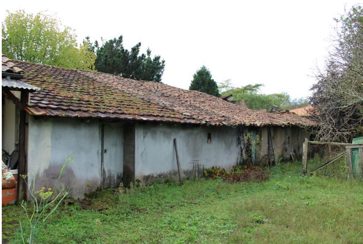
Chai : façade nord.
