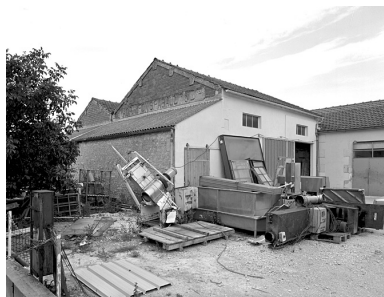
Caséinerie portant l'inscription Magrini, Ponis, Rabault et Cie vue du nord est. Phot. Marc Deneyer IVR54_19971701165V
