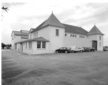
Vue prise de l'est. Phot. Marc Deneyer IVR54_19971701162V
