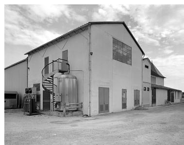
Chaufferie vue du sud. Phot. Marc Deneyer IVR54_19971701163V
