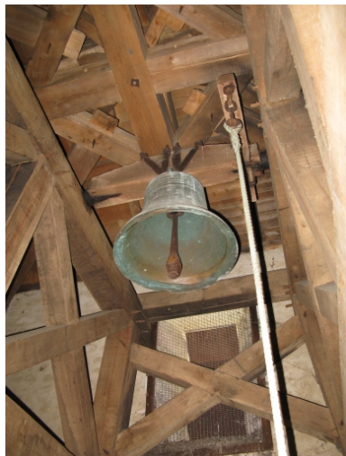
Vue d'ensemble de la cloche. Phot. Yannis Suire IVR54_20101702499NUCA
