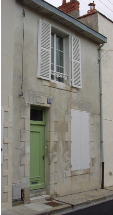
Vue générale. Phot. Claire Peyron IVR54_20041705665NUCA
