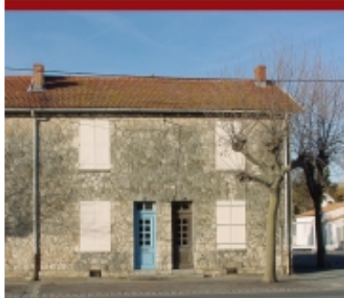
Vues d'élévations. Phot. Yann Cussey IVR54_20071704966NUCA
