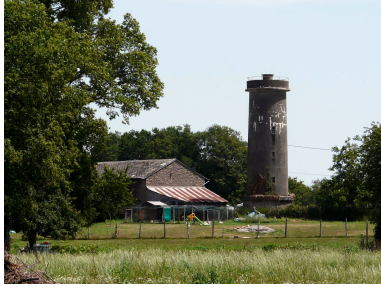
Vue générale du château d'eau.
