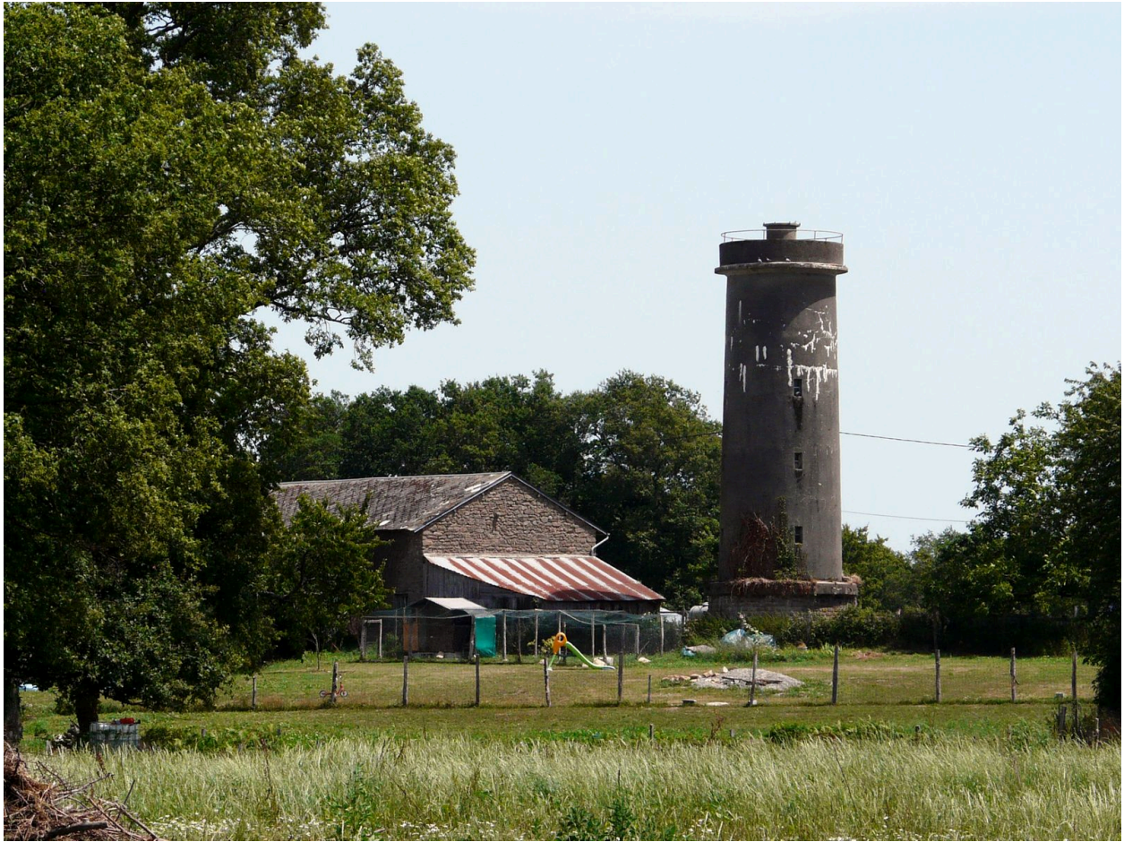
Vue générale du château d'eau.
