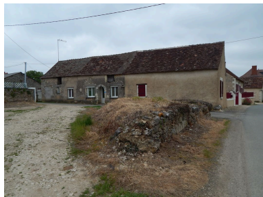
Élévation occidentale. Phot. Paul Maturi IVR75_20198605984NUCA
