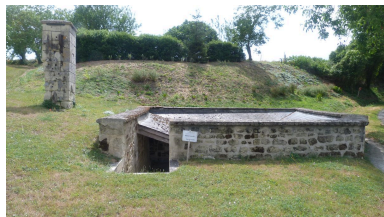
Vue générale du lavoir à impluvium. Phot. Laëtitia Douski IVR75_20197903001NUCA
