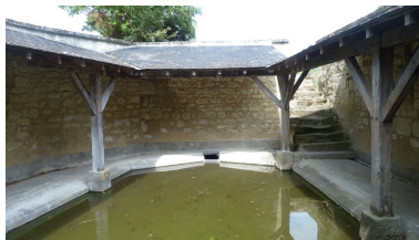
Vue de l'escalier permettant l'accès au bassin du lavoir. Phot. Laëtitia Douski IVR75_20197903003NUCA
