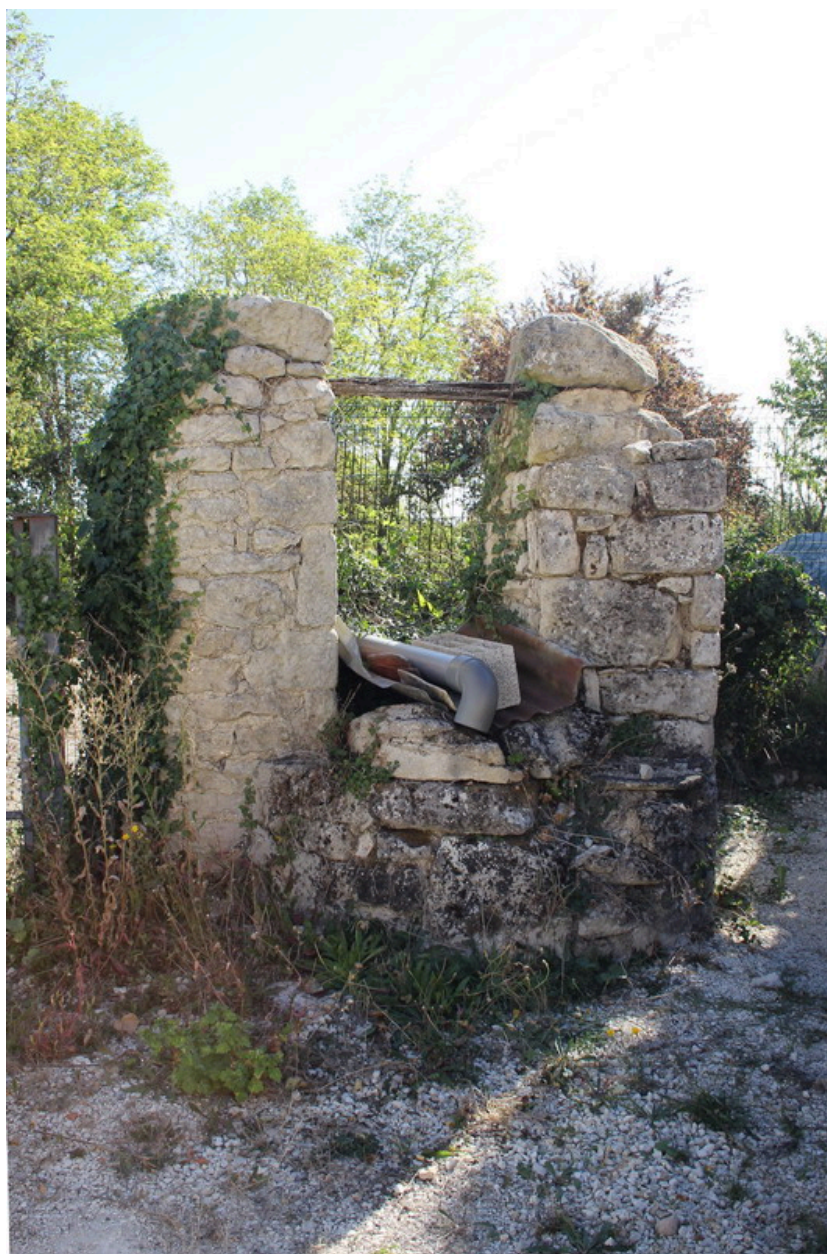
Une vue du puits, depuis l'ouest.
