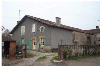
Vue générale. Phot. Yann Ourry IVR54_20041608273NUCA
