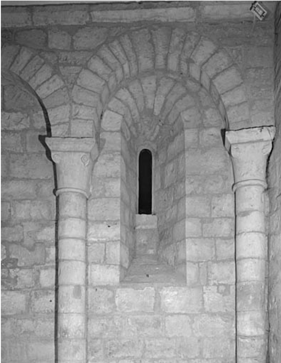
Choeur, arcature et fenêtre de gauche.
