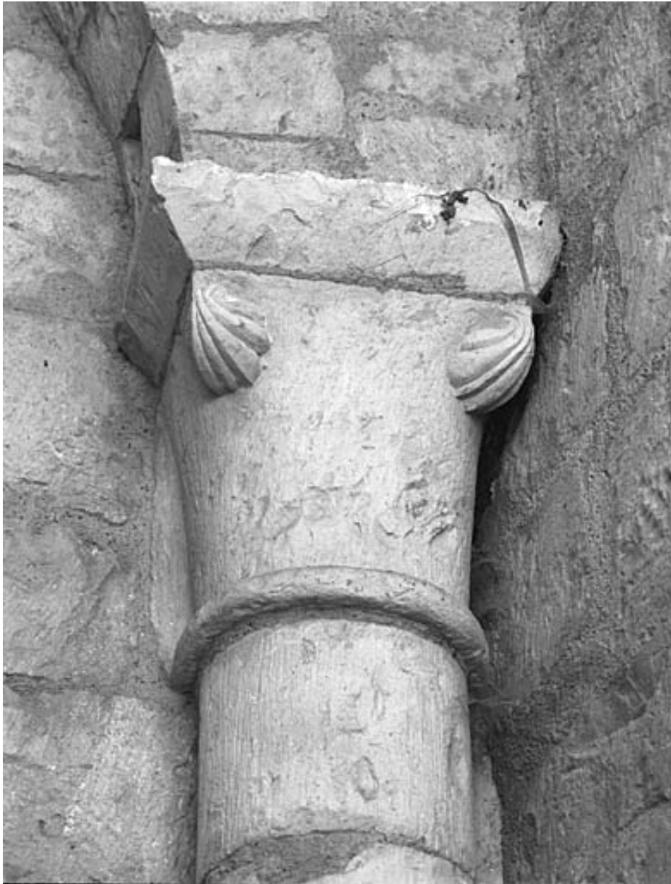
Choeur, arcature et fenêtre de gauche.
