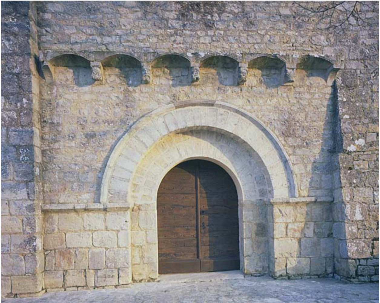
Façade ouest, portail.
