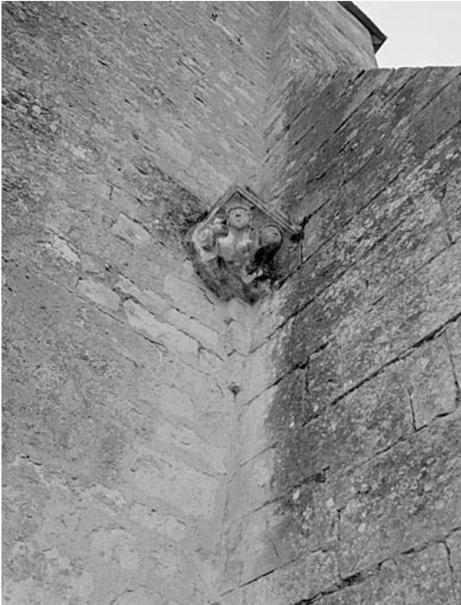
Elévation nord, jonction entre le clocher et le contrefort, chapiteau remployé.
