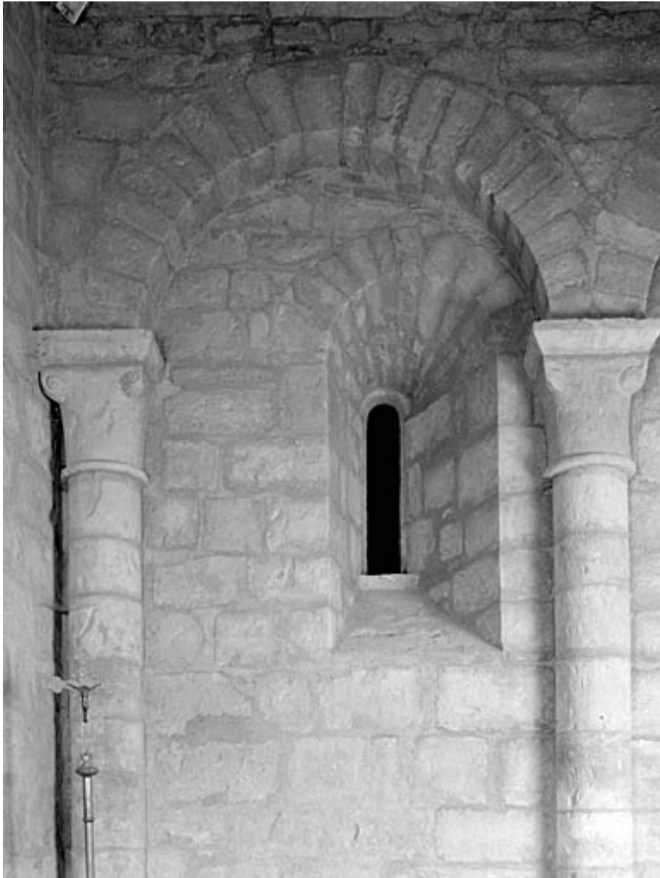
Choeur, arcature et fenêtre de droite.
