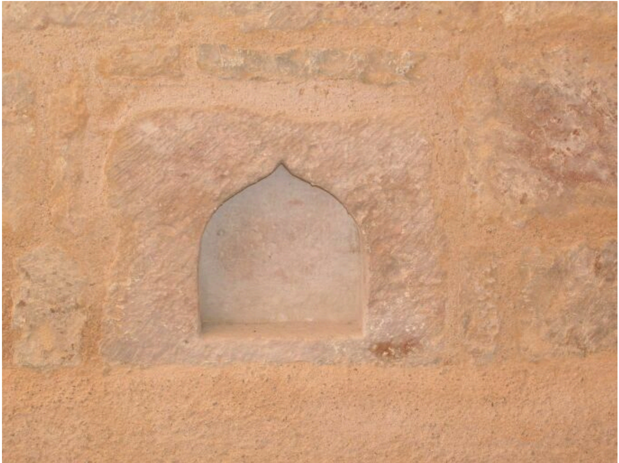
Intérieur, niche dans le mur nord.
