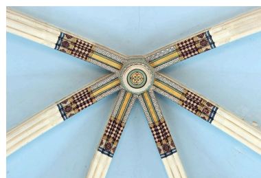
Voûte du chœur. Phot. Jean-Philippe Maisonnave IVR72_20184001983NUC2A
