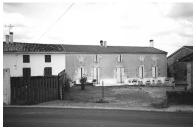
Une vue du logement de l'ancienne ferme, depuis le sud-ouest. Phot. Nathalie Lhuissier IVR54_20051703068Z
