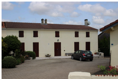
Une vue du logement de l'ancienne ferme, depuis le sud-ouest. Phot. Nathalie Lhuissier IVR75_20191701727NUCA
