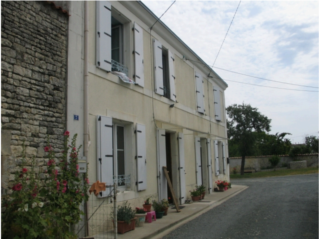
La façade principale du logement.
