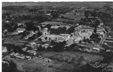
Carte postale (collection particulière) : vue aérienne du village, baraquements construits sur la place, rue du 19 mars 1962 (après guerre, le clocher de l'église est en ruine). IVR72_20143303045NUC1A
