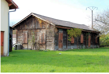
Vue d'ensemble. Phot. Claire Steimer IVR72_20143303490NUC2A
