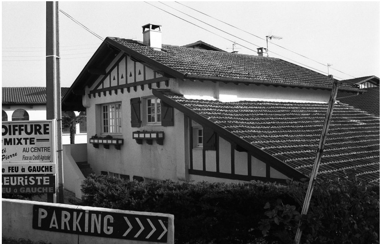
Maison, 2 rue des écoles : ensemble depuis le nord-ouest.
