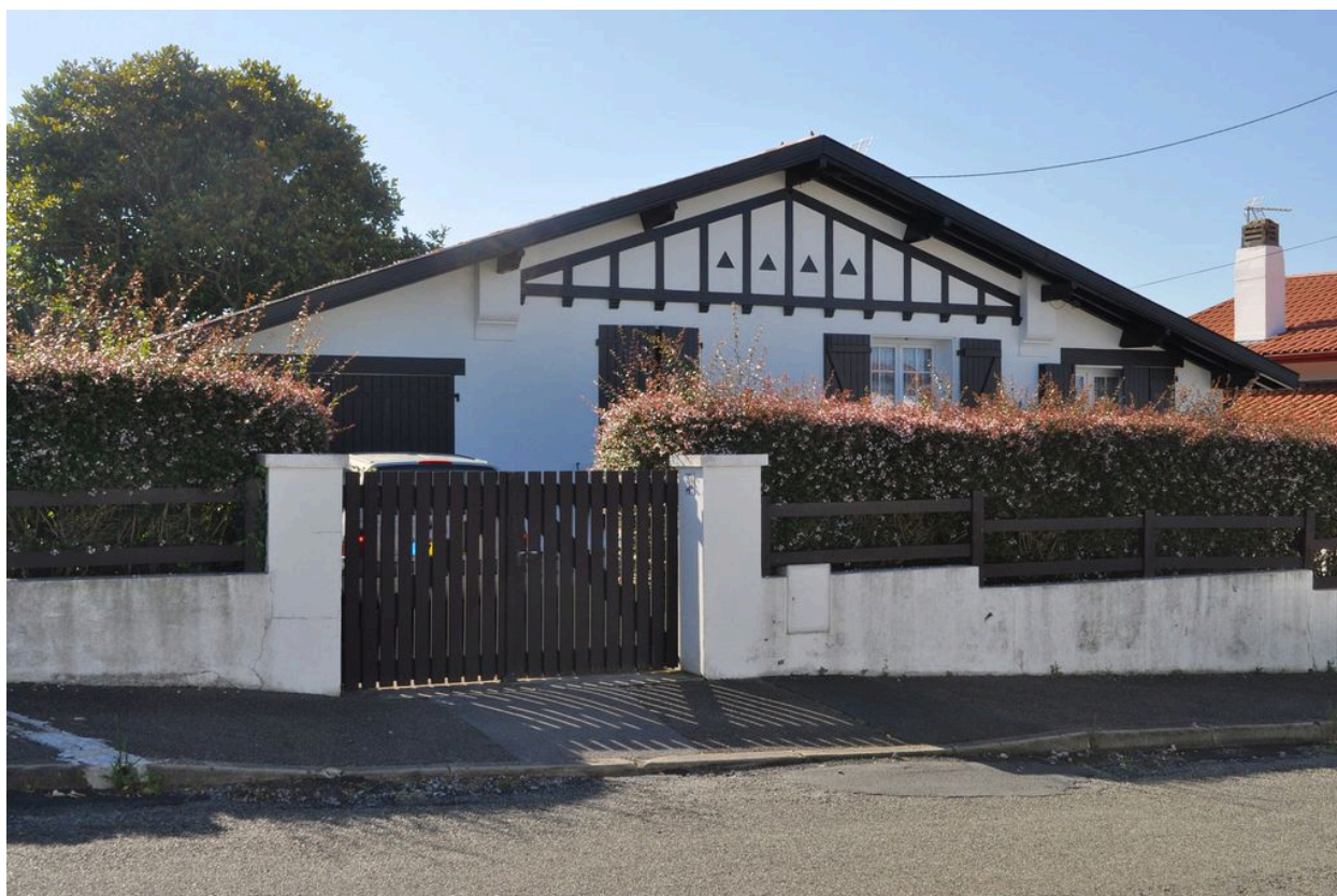
Maison, 19 rue des écoles, vue de la façade ouest.
