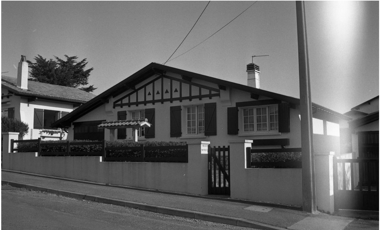
19 rue des écoles, élévation sur la rue des Ecoles vers 1994.
