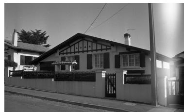
19 rue des écoles, élévation sur la rue des Ecoles vers 1994. Phot. Pierre-Jean Harté-Lasserre IVR72_19996400070Z
