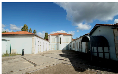
Vue d'ensemble depuis l'ouest. Phot. Jean-Philippe Maisonnave IVR72_20184002442NUC2A
