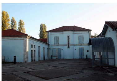
Vue d'ensemble depuis l'ouest. Phot. Jean-Philippe Maisonnave IVR72_20184002445NUC2A
