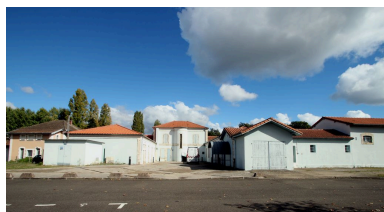
Vue d'ensemble depuis l'ouest. Phot. Jean-Philippe Maisonnave IVR72_20184002441NUC2A
