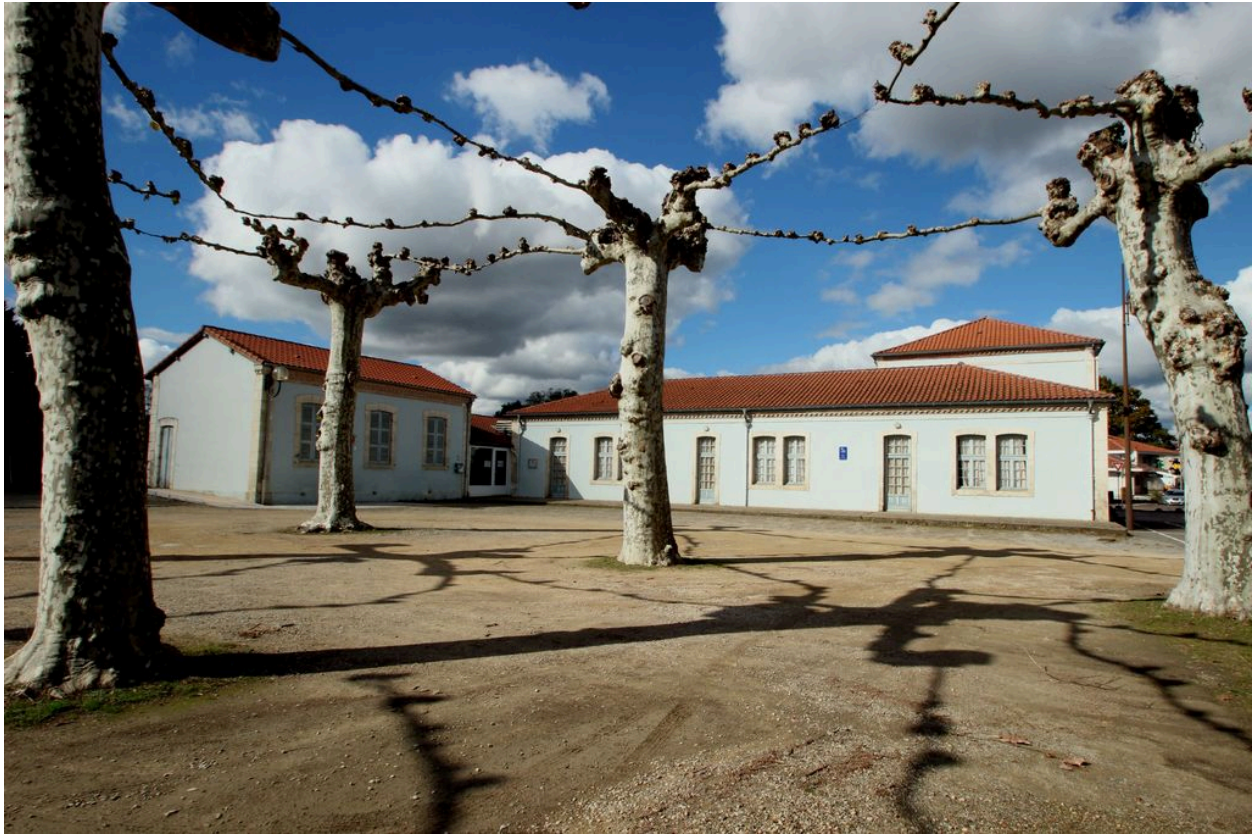
Aile sud depuis le sud.
