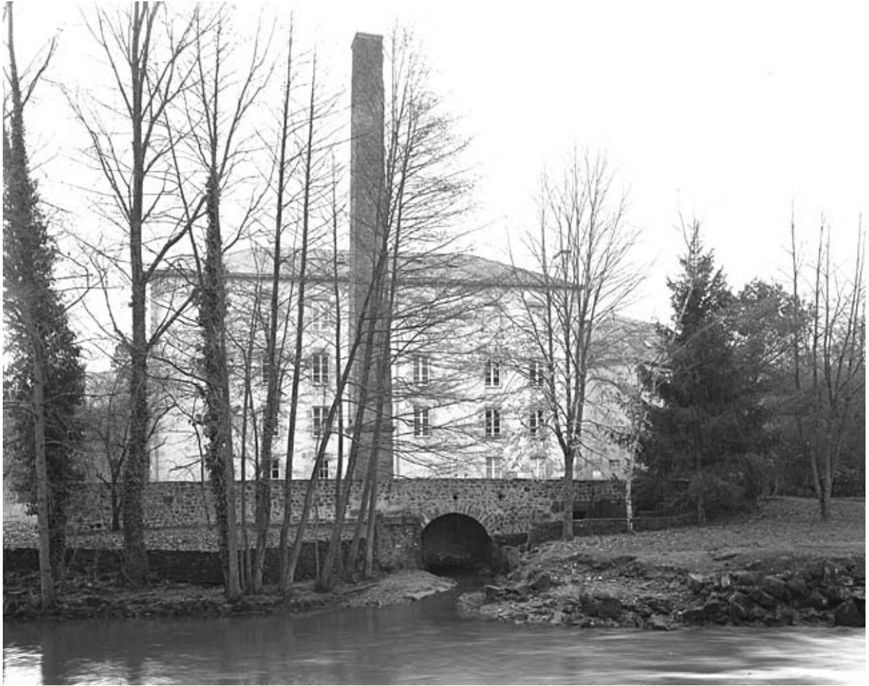
Elévation postérieure et cheminée.
