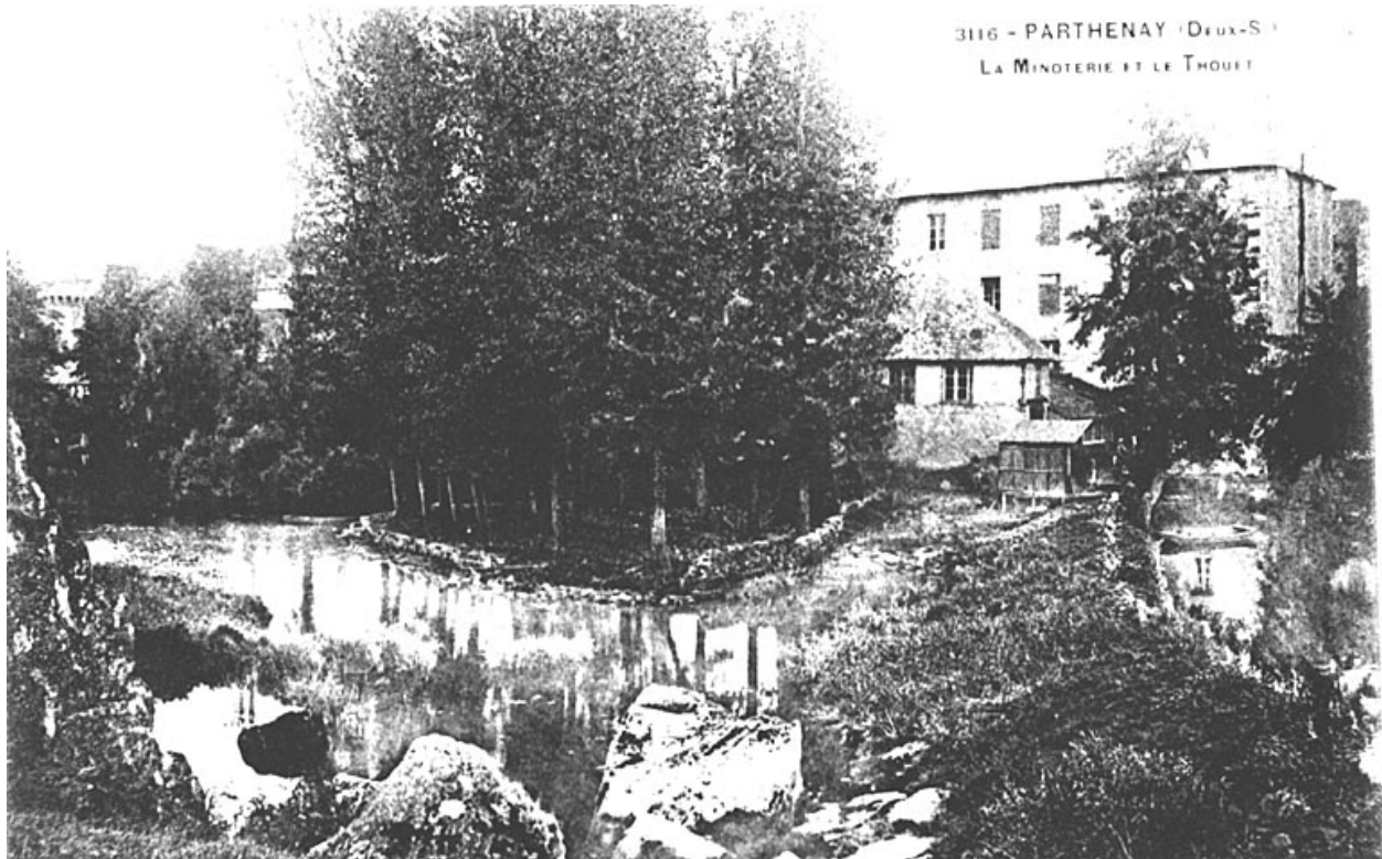
Vue prise du nord
