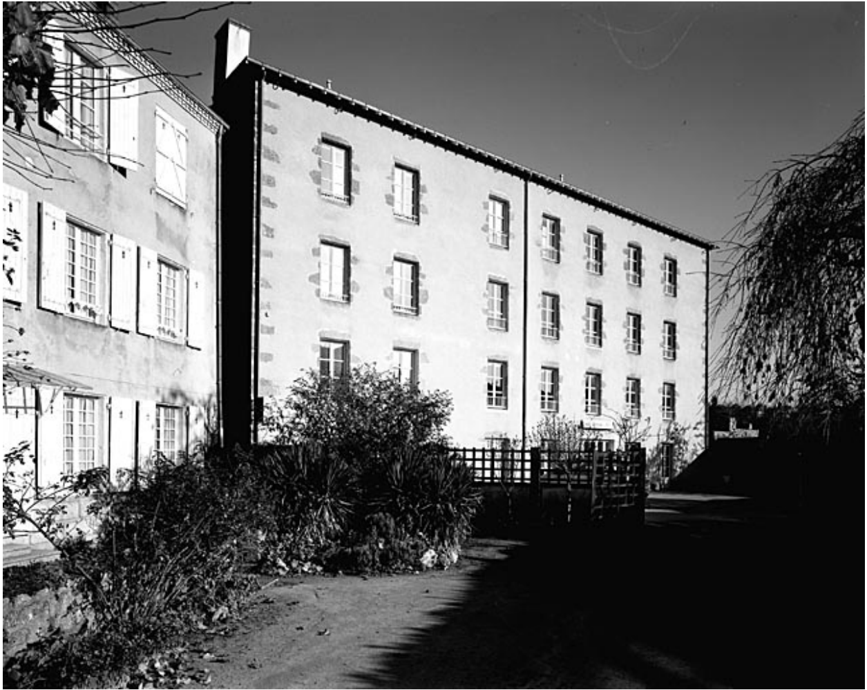
Elévation antérieure vue du sud-ouest.
