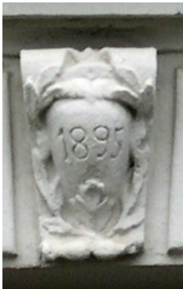
Détail d'un linteau de porte. Phot. Christine Redien-Lairé IVR54_20061700531NUCA
