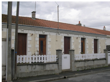
Façades. Phot. Christine Redien-Lairé IVR54_20061700530NUCA
