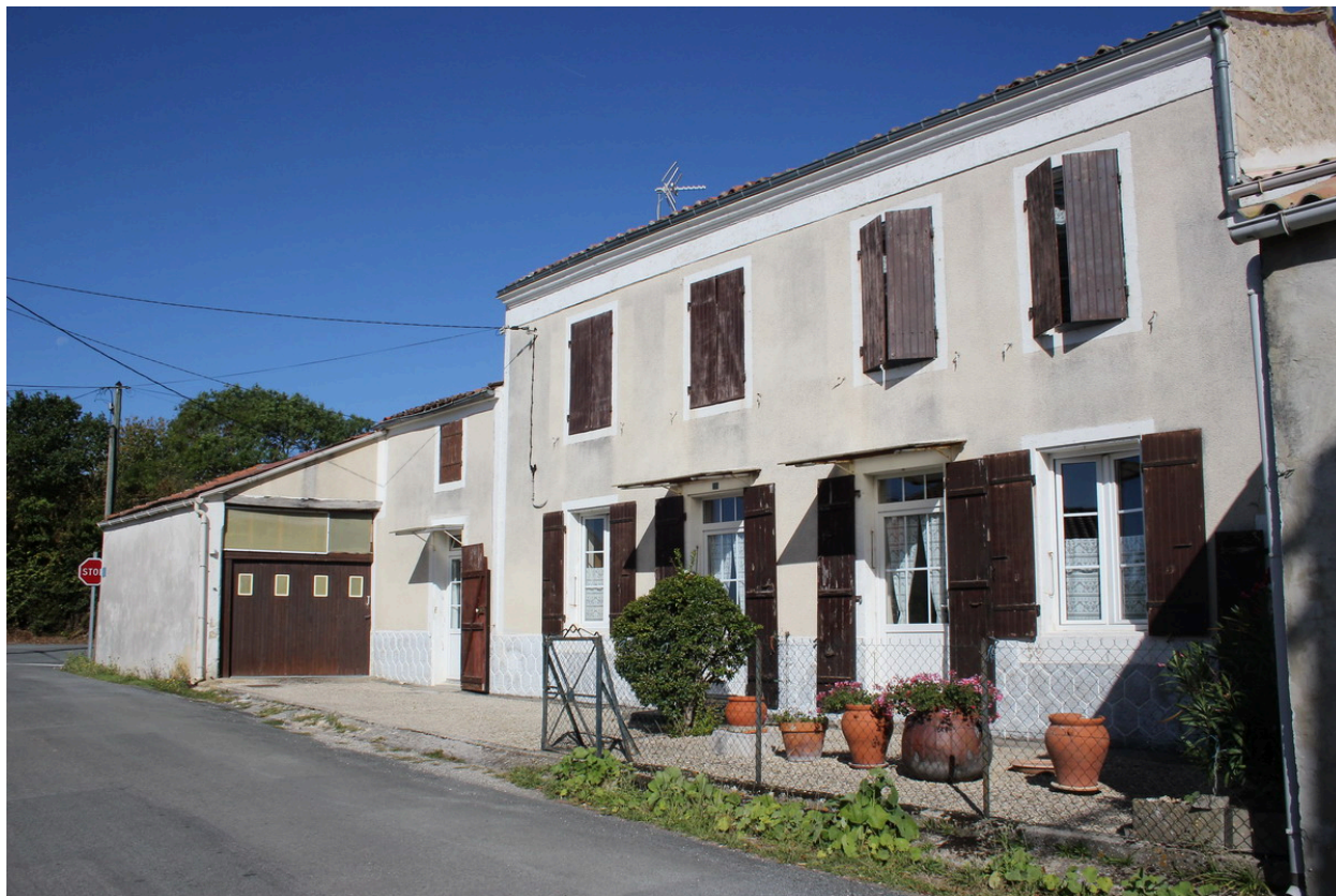
Une autre vue d'ensemble de l'ancienne ferme, depuis le sud-est.
