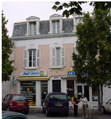
Vue générale. Phot. Claire Peyron IVR54_20041706504NUCA
