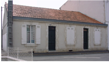
Vue générale. Phot. Claire Peyron IVR54_20041705184NUCA
