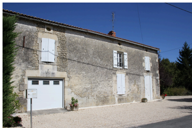
Une vue du logement de l'ancienne ferme et de la dépendance accolée, depuis le sud-ouest. Phot. Nathalie Lhuissier IVR75_20191702384NUCA
