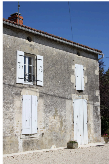
Une vue du logement de l'ancienne ferme, depuis le sud-ouest. Phot. Nathalie Lhuissier IVR75_20191702385NUCA
