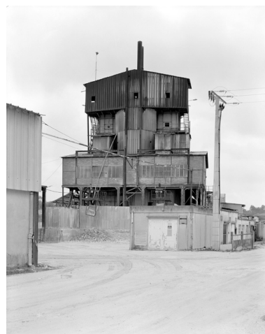
Le four de cuisson de l'argile. Phot. Marc Deneyer IVR54_19881600582V
