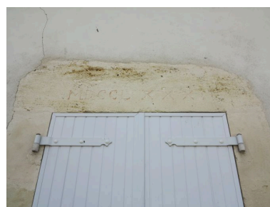
La date 1782, en chiffres romains, au-dessus d'une ouverture dans la rue des Basse coutures. Phot. Yannis Suire IVR54_20131705993NUCA
