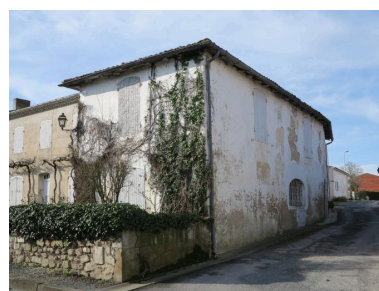
L'aile nord vue depuis l'est. Phot. Yannis Suire IVR54_20131705308NUCA
