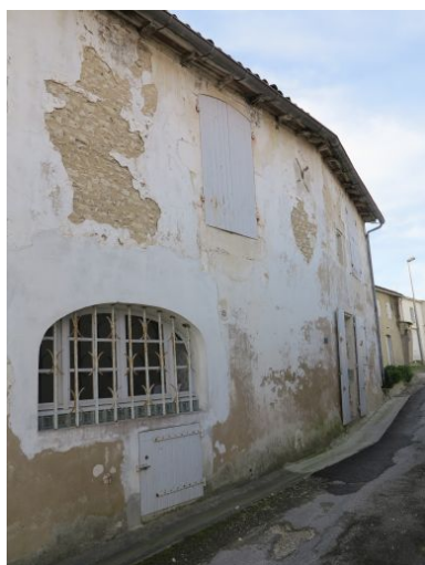
Ouvertures de l'aile nord. Phot. Yannis Suire IVR54_20131705309NUCA
