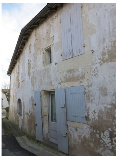
Ouvertures de l'aile nord. Phot. Yannis Suire IVR54_20131705312NUCA
