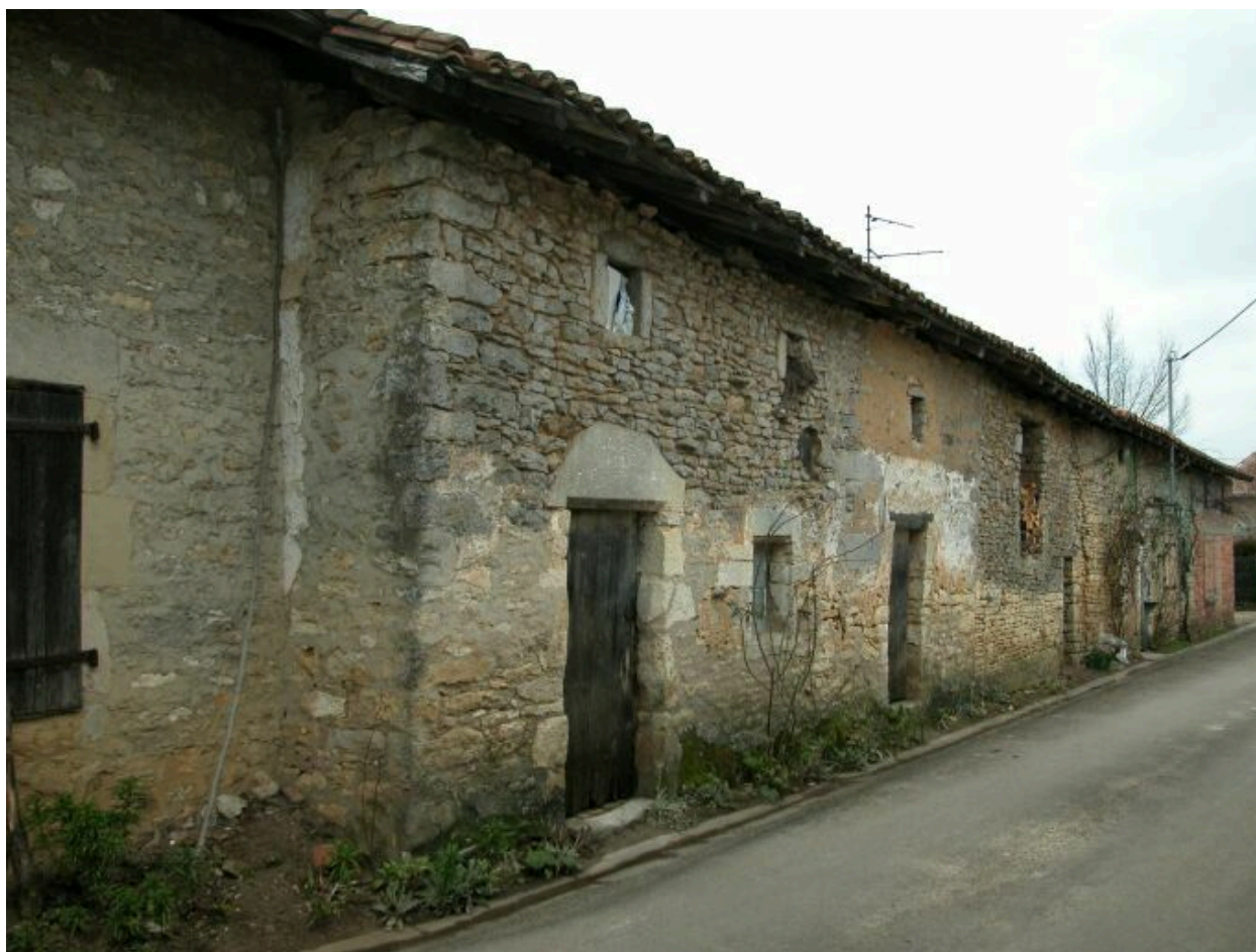
Elévation antérieure de la maison.
