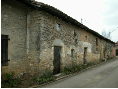
Elévation antérieure de la maison.
