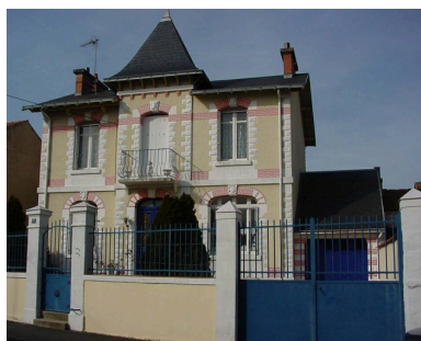
Vue générale. Phot. Claire Peyron IVR54_20041703518NUCA
