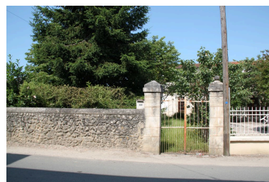
Mur de clôture et portail du jardin. Phot. Claire Steimer IVR72_20163301599NUC2A
