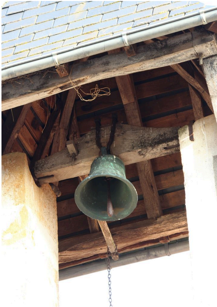
Ensemble dans le clocher-mur.
