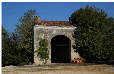
Une vue du hangar de l'ancienne ferme, depuis le sud-ouest.
