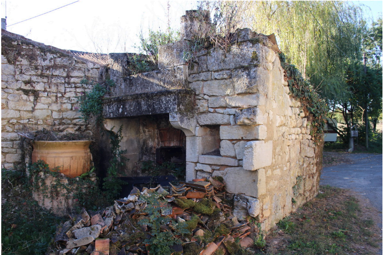
Une vue du four, depuis le nord.
