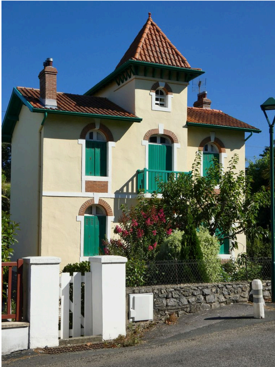
Vue de la façade principale et de la clôture.
