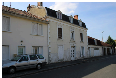
Une vue d'ensemble de l'ancien hôtel, depuis le sud-est. Phot. Nathalie Lhuissier IVR75_20181702669NUCA
