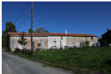
Une vue d'ensemble de l'ancienne ferme, depuis le sud.
