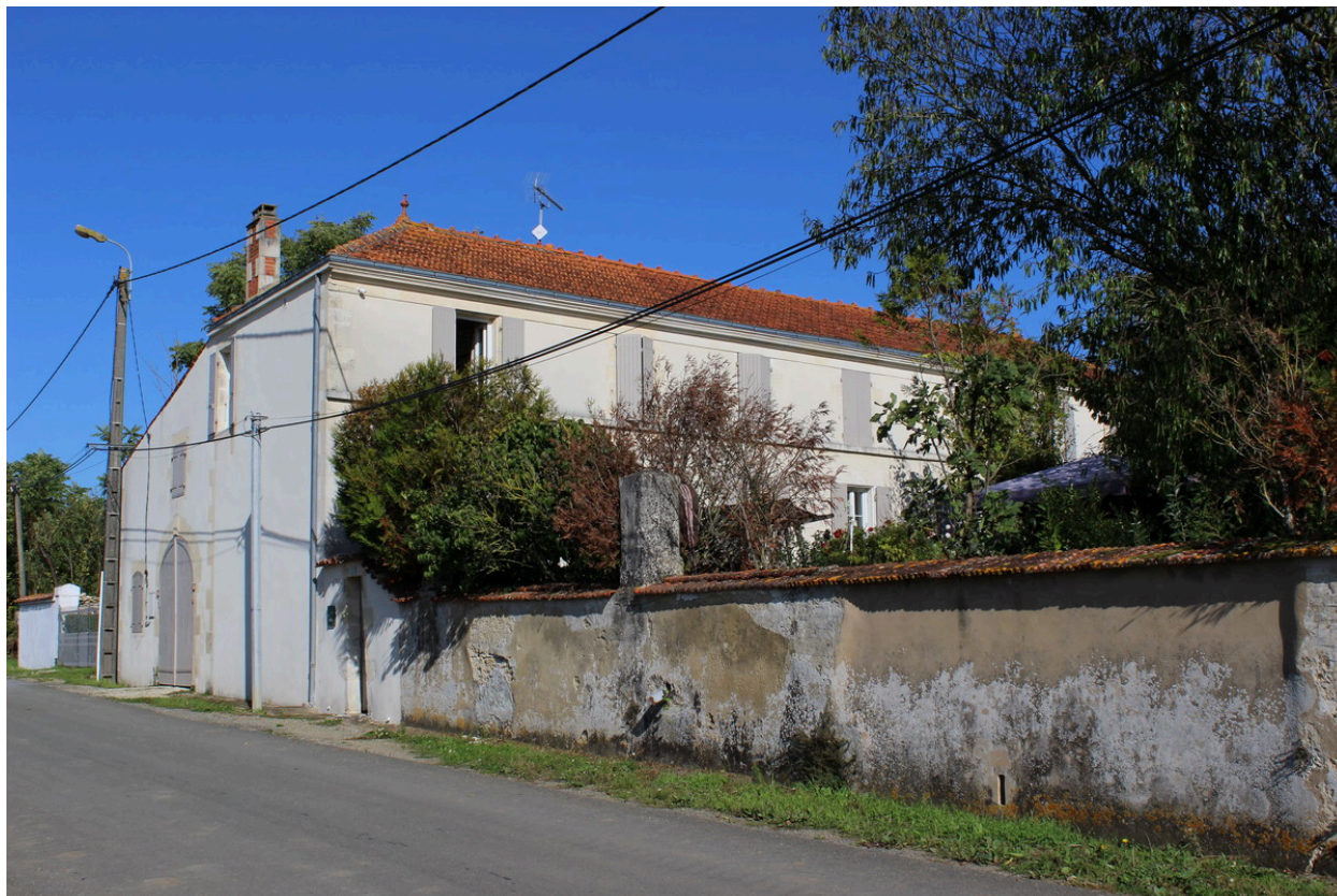
Une vue de l'ancienne ferme, depuis le sud-ouest.
