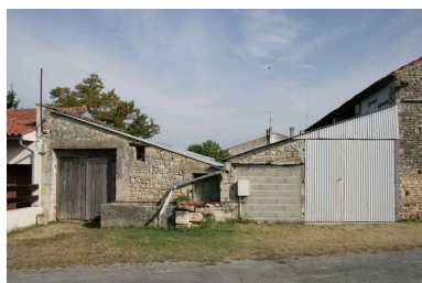
Une vue des dépendances en bordure de rue, depuis le sud-est. Phot. Mathieu Bordes IVR54_20091701711NUCA
