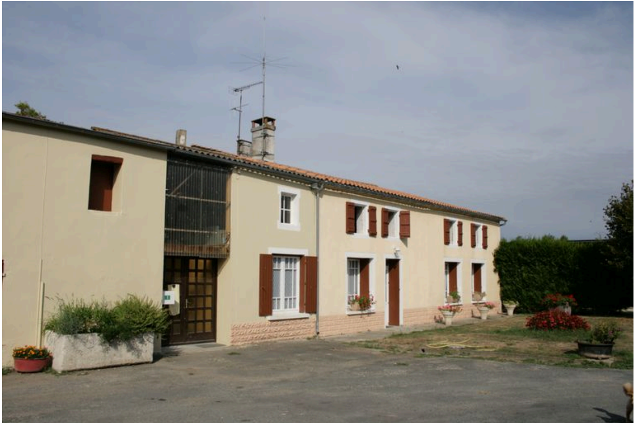
Le logement actuel et une partie des dépendances accolées, depuis le nord-est.
