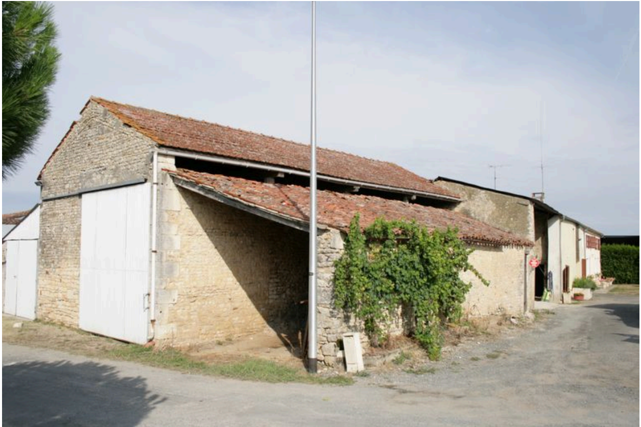
Une vue d'ensemble de l'ancienne ferme, depuis le sud-est.
