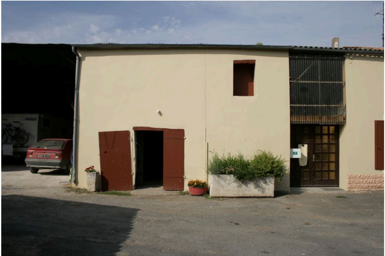
L'ancienne étable, depuis le nord-est.
