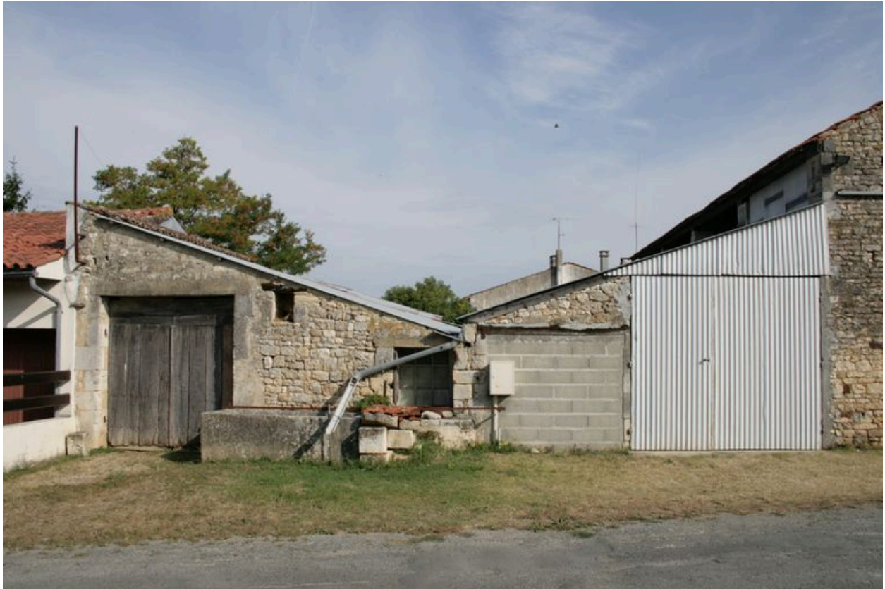
Une vue des dépendances en bordure de rue, depuis le sud-est.
