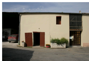
L'ancienne étable, depuis le nord-est. Phot. Mathieu Bordes IVR54_20091701714NUCA
