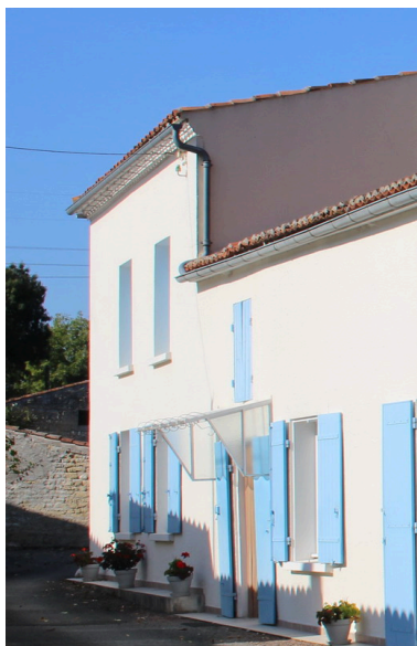
Une vue du premier logement de l'ancienne ferme. Phot. Nathalie Lhuissier IVR75_20181703183NUCA
