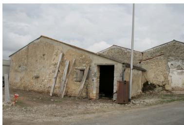
Une partie des dépendances, depuis le nord-est. Phot. Cécilia Guiberteau IVR54_20091701398NUCA
