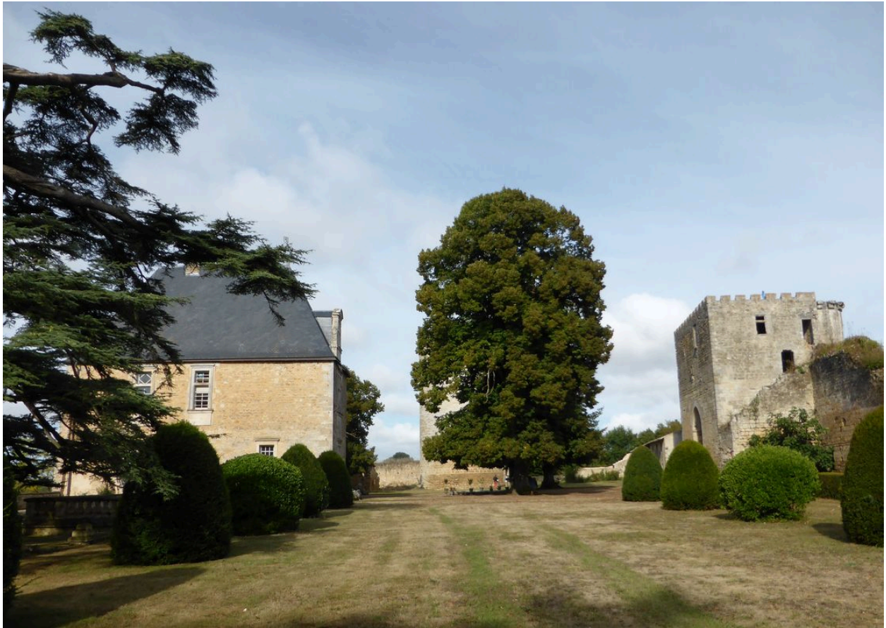
Vue intérieure de la cour.
