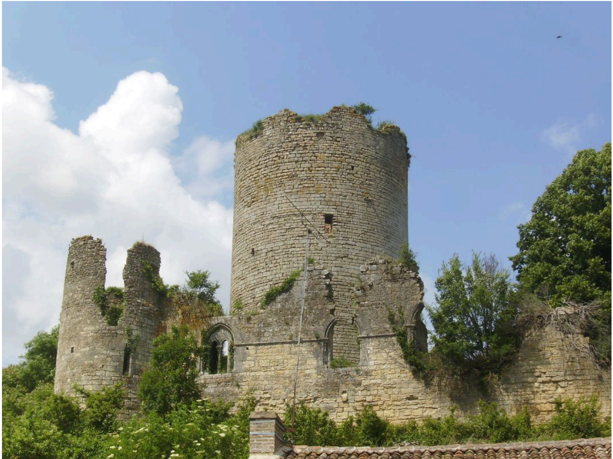
Vue d'ensemble au sud.
