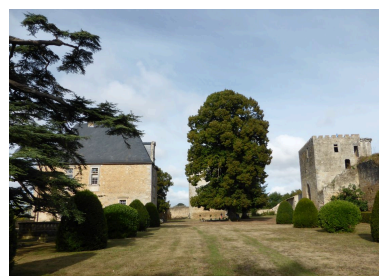
Vue intérieure de la cour. Phot. Marie-Pierre Baudry IVR54_20178611565NUCA
